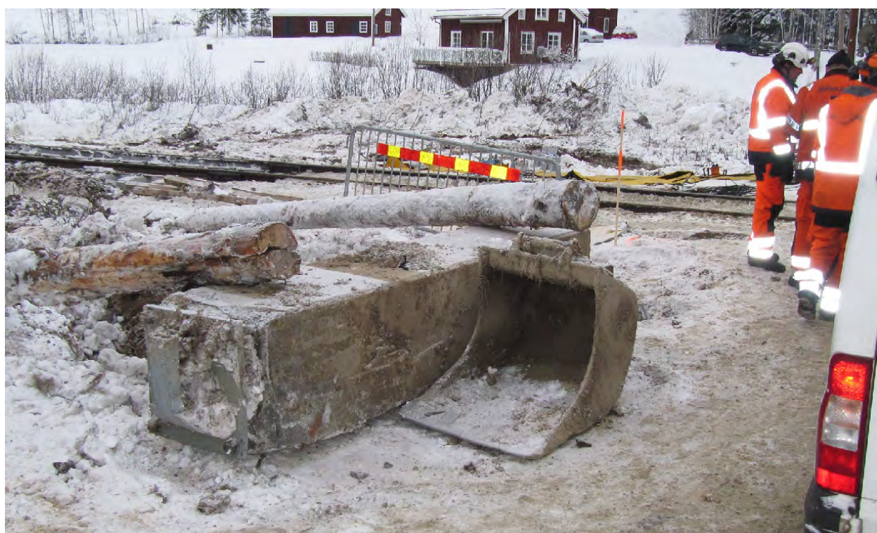
Bild 8: Fundamentet till signalanordningen.
