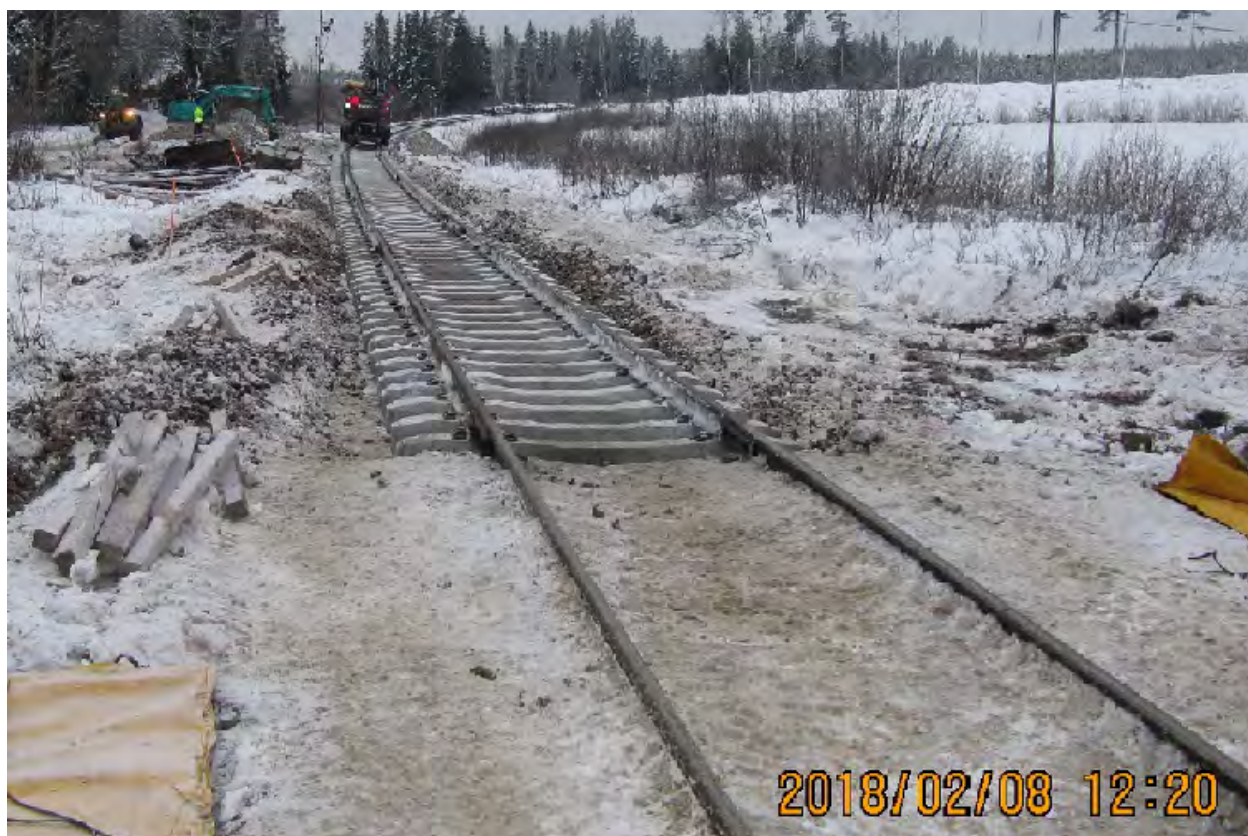
Bild 7: Rälbyte.
