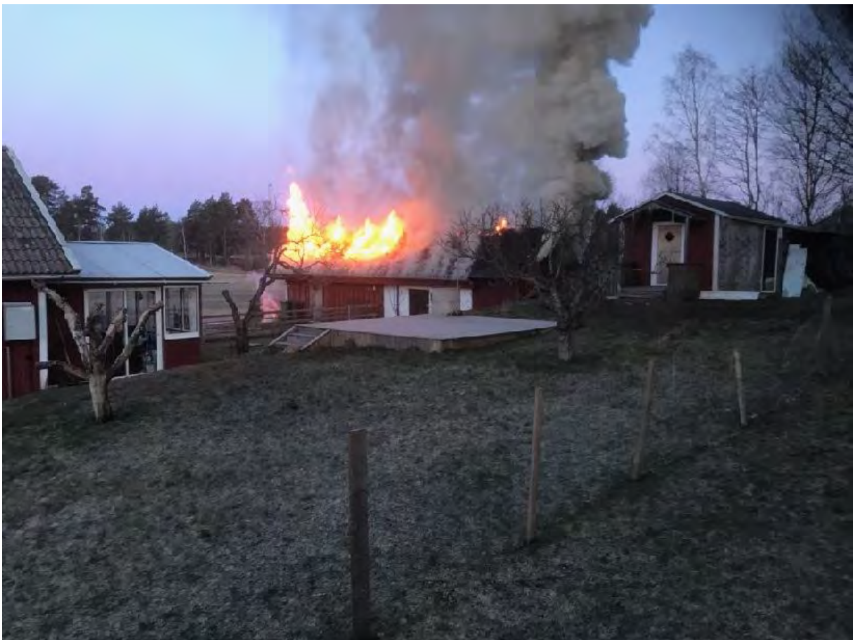
Bild 4: Brand med lågor på plåttaket, kraftig rök från högra gaveln.
