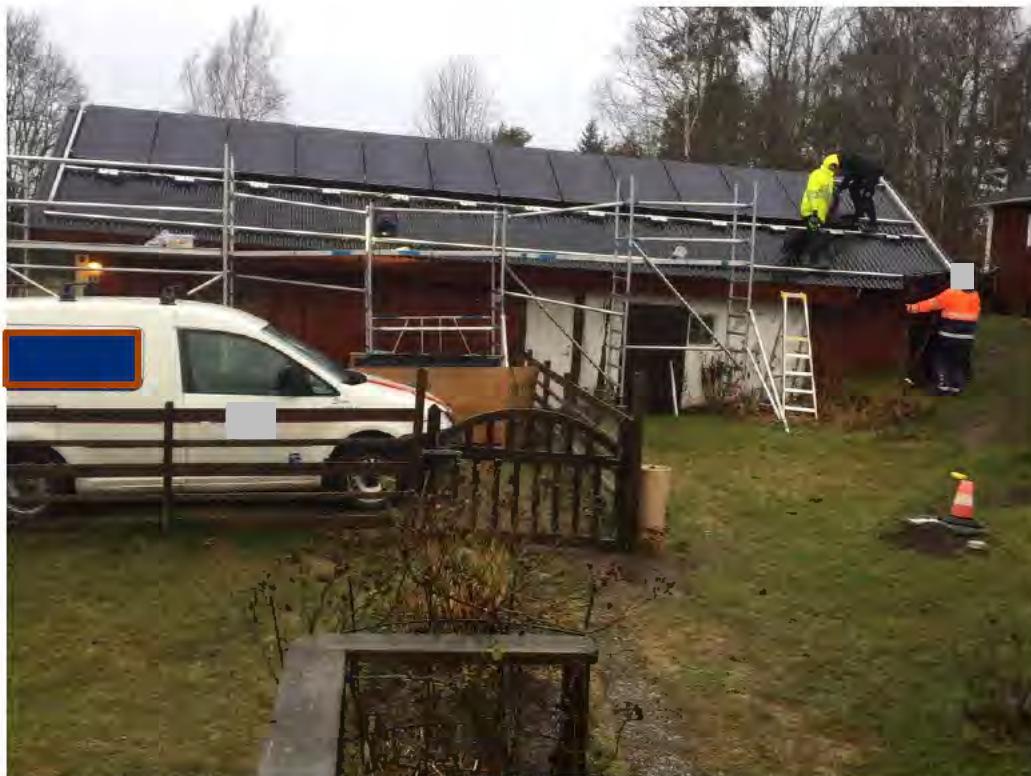
Bild 3: Montering av solcellspaneler, februari 2020. Foto taget av ägare.
