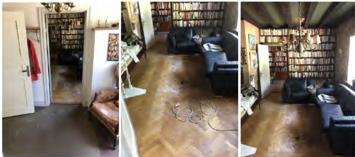
Figur 2, 3 och 4. Utrymmet på väg in mot rummet där den boende satt i soffan, brandrummet.
