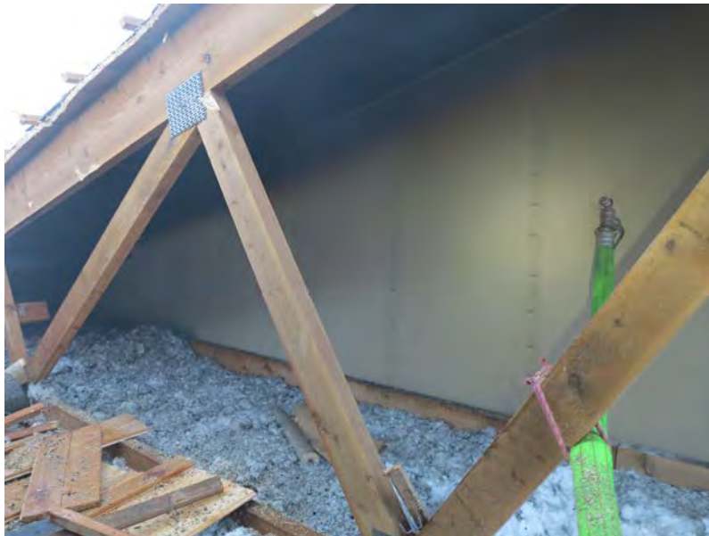
Bild 6. Avskiljande vägg i vind mot drabbad lägenhet.
