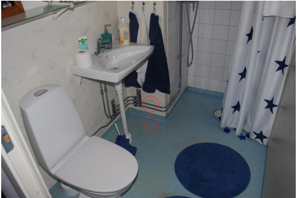
Foto 5. Badrum i lägenhet med otäthet mot schakt.
