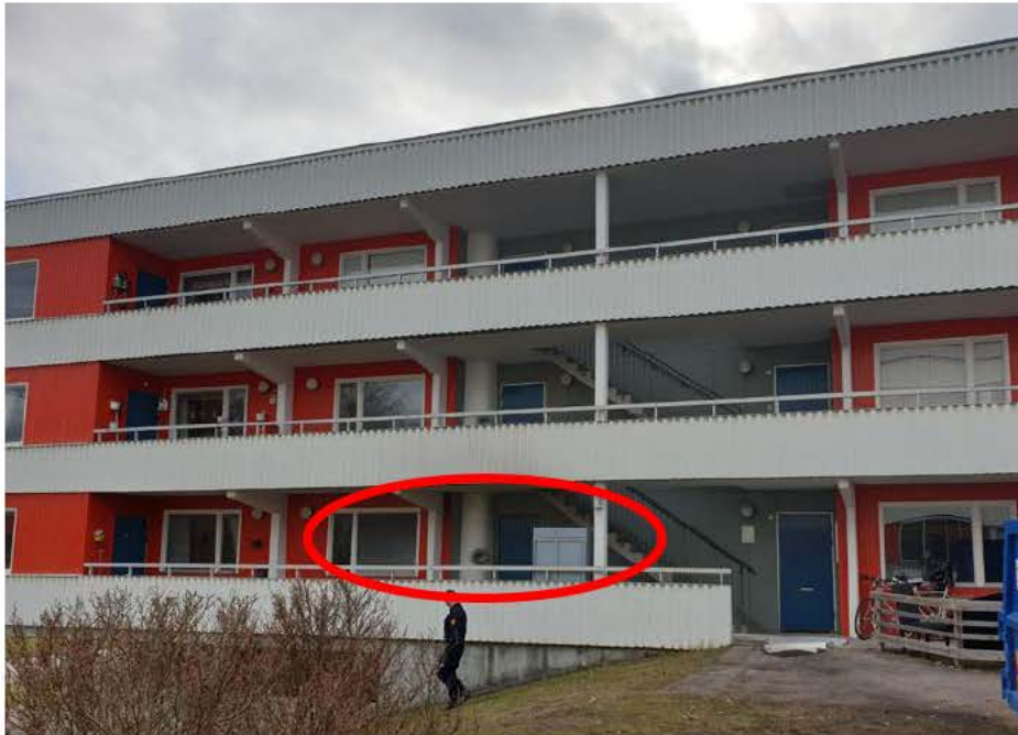
Entrédörr och inträngningsväg samt köksfönster till den drabbade lägenheten. (Bilden är tagen när saneringsfirman påbörjat saneringsarbetet)
