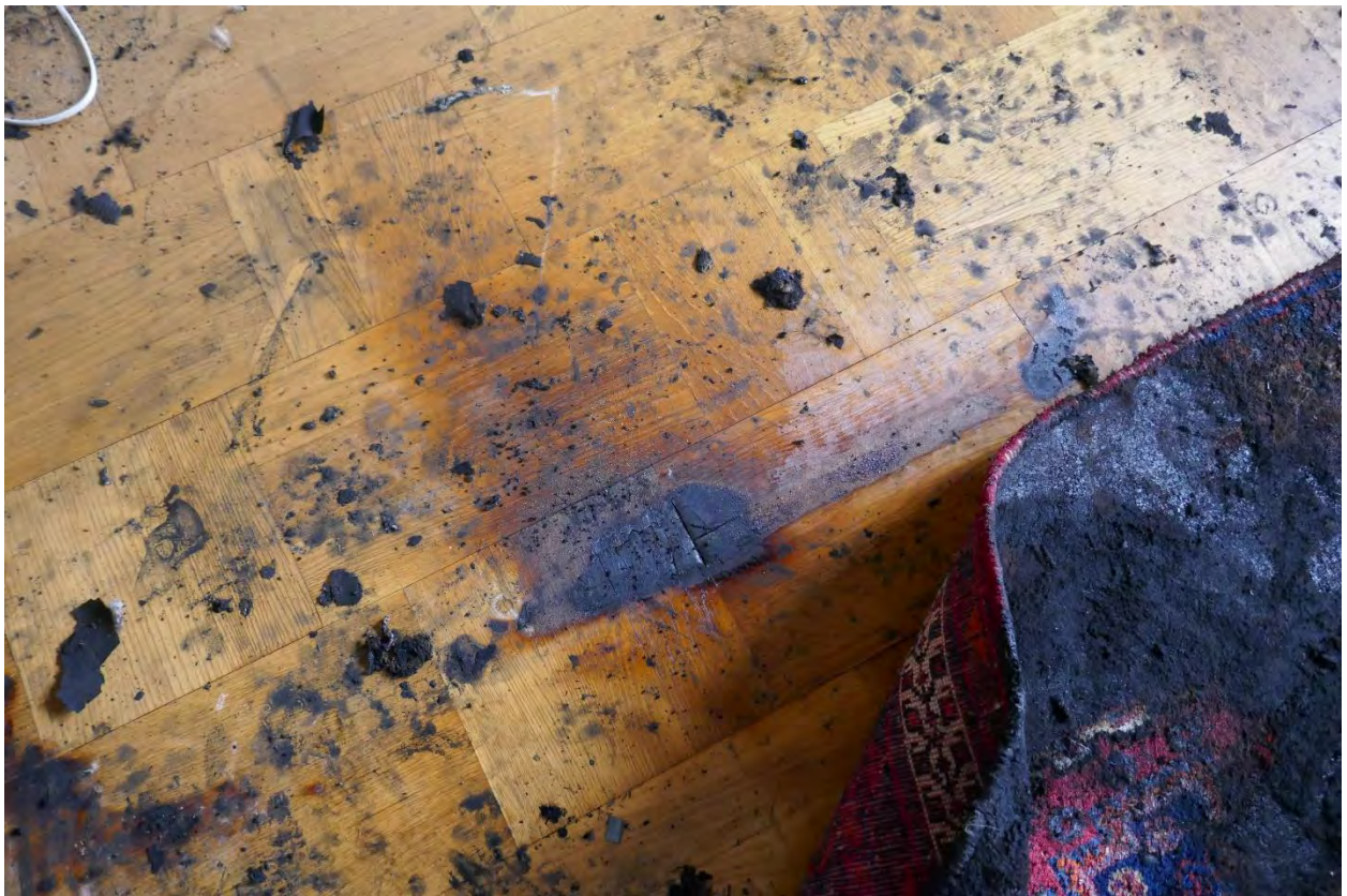
Figur 3 Golv i vardagsrum
