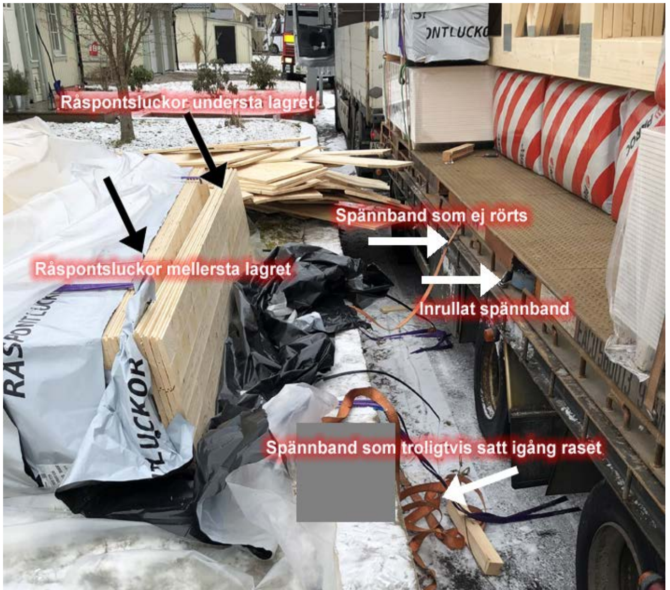
Bild 3. Paket med råspontsluckor samt dom tre spännband som lossats. Råspontsluckornas tredje bunt ligger till vänster utanför bilden.
