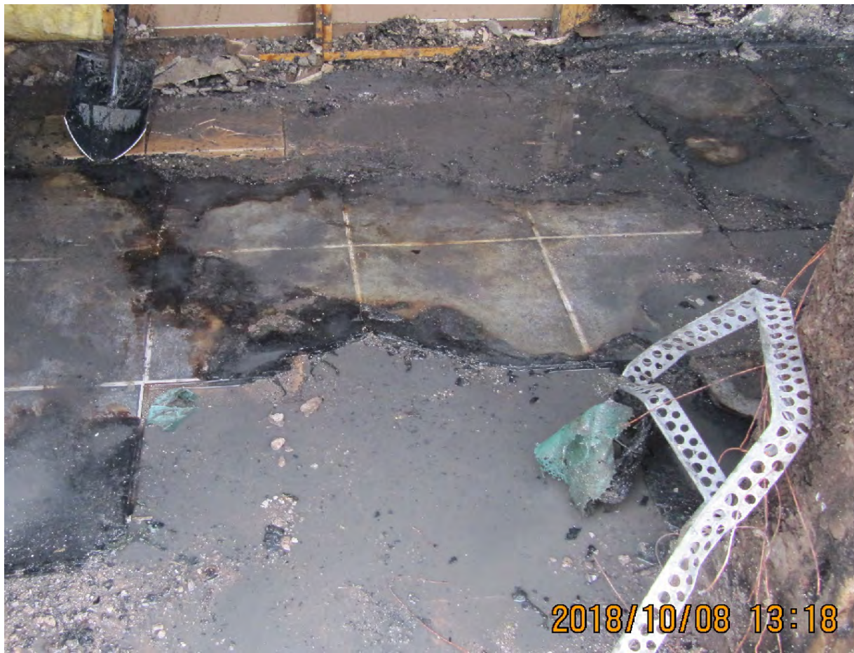
Bild 10: Golv innanför entrédörr.
