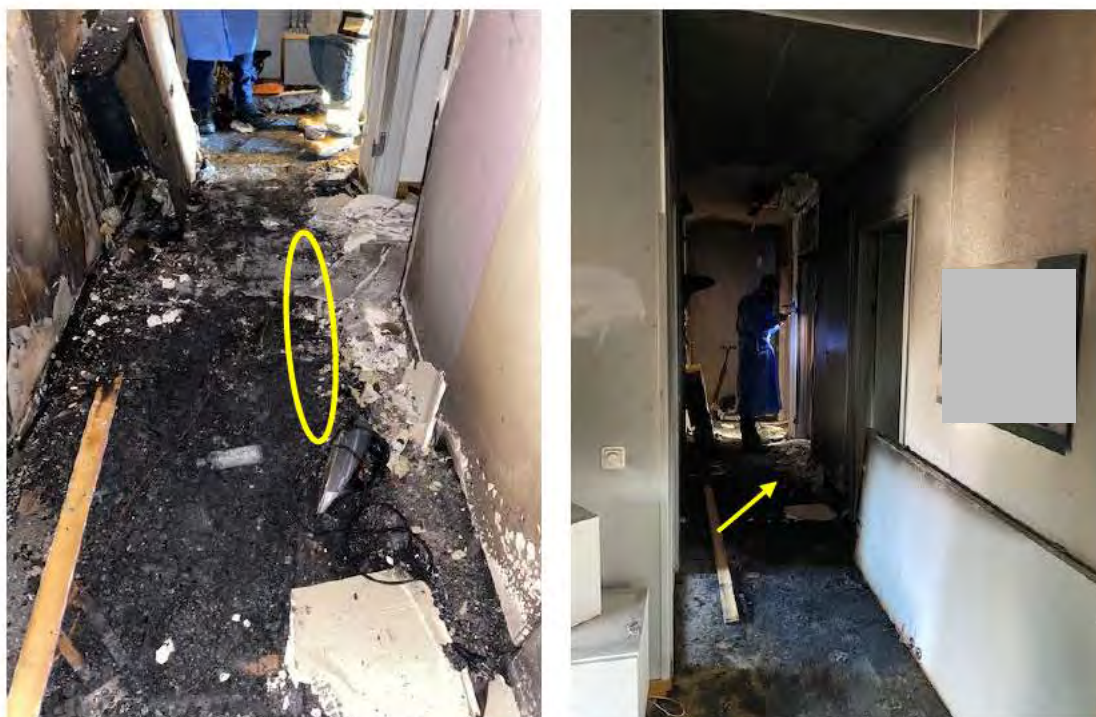
Bilder på hall där branden startade. El- sparkykelns position i hallen utanför klädkammaren, gul markering. I bilden till höger syns borttagen dörr till klädkammaren.
