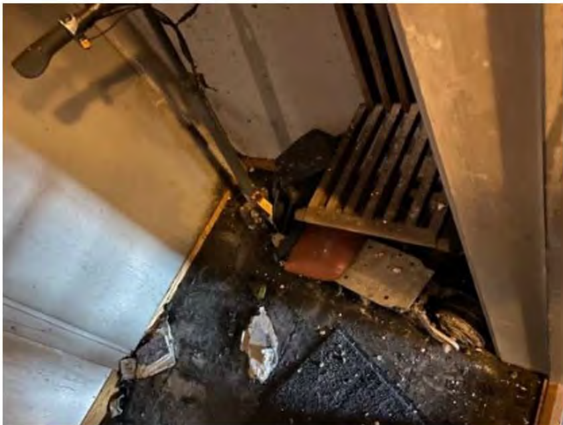
Bild. El-sparcykeln (på bild flyttad). Batteripaketet som brann var placerad under stå ytan på cykeln.
