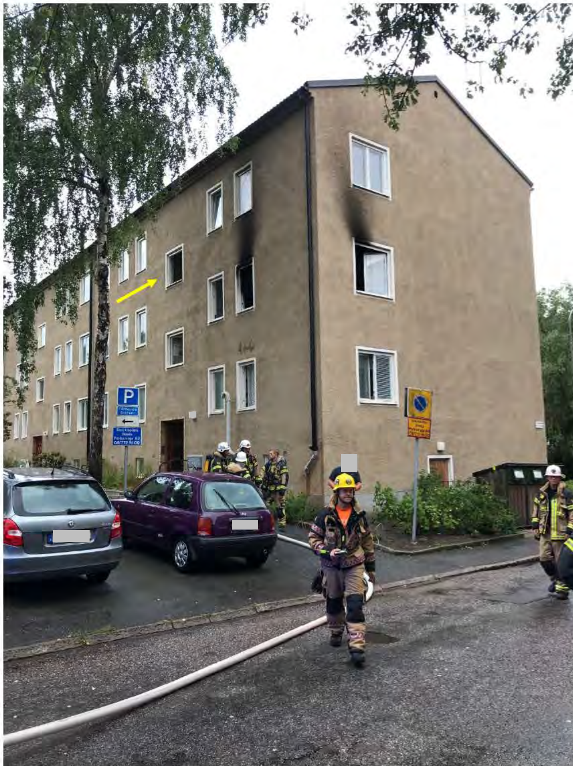
Bild. Brandlägenheten plan 2. På fasad synliga sot-avlagningar från fönstren till köket. Fönster för brandgasventilering av trapphus gul markering.
