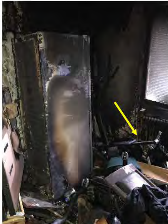
Bild. Tv, Köksdörr med synlig värmepåverkan mot hall öppen. Th, El-sparkcykelns placering i köket (ligger under bråten och ej synlig i bild) gul markering.
