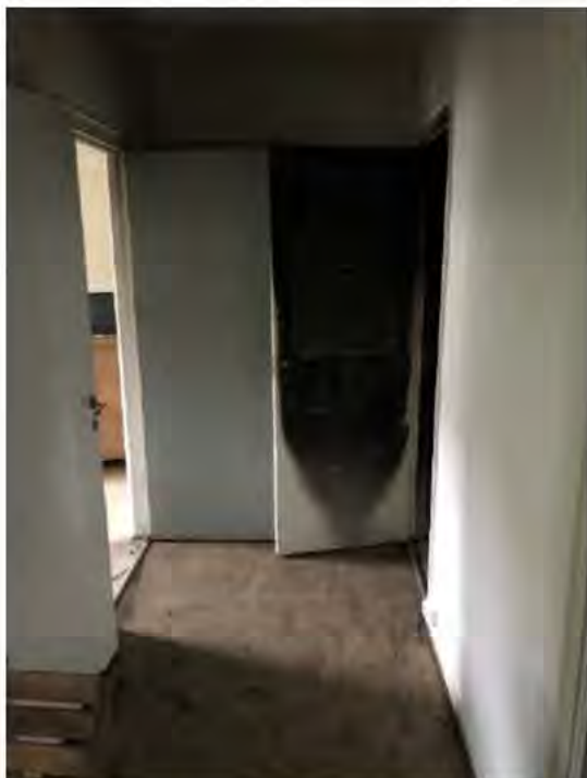
Bild. Tv, Köksdörr med synlig värmepåverkan mot hall öppen. Th, El-sparkcykelns placering i köket (ligger under bråten och ej synlig i bild) gul markering.
