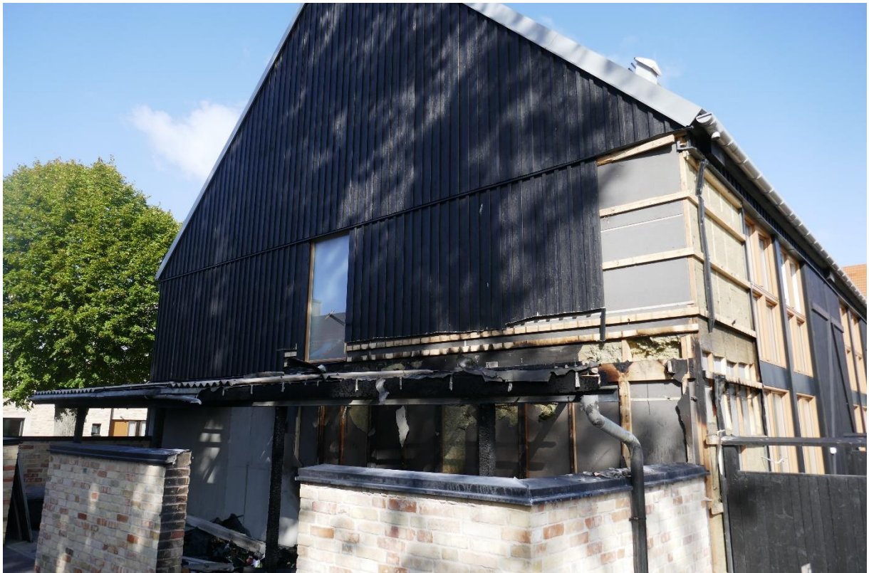
Foto 3. Friläggning av fasaden på gaveln ovanför skärmtaket.
