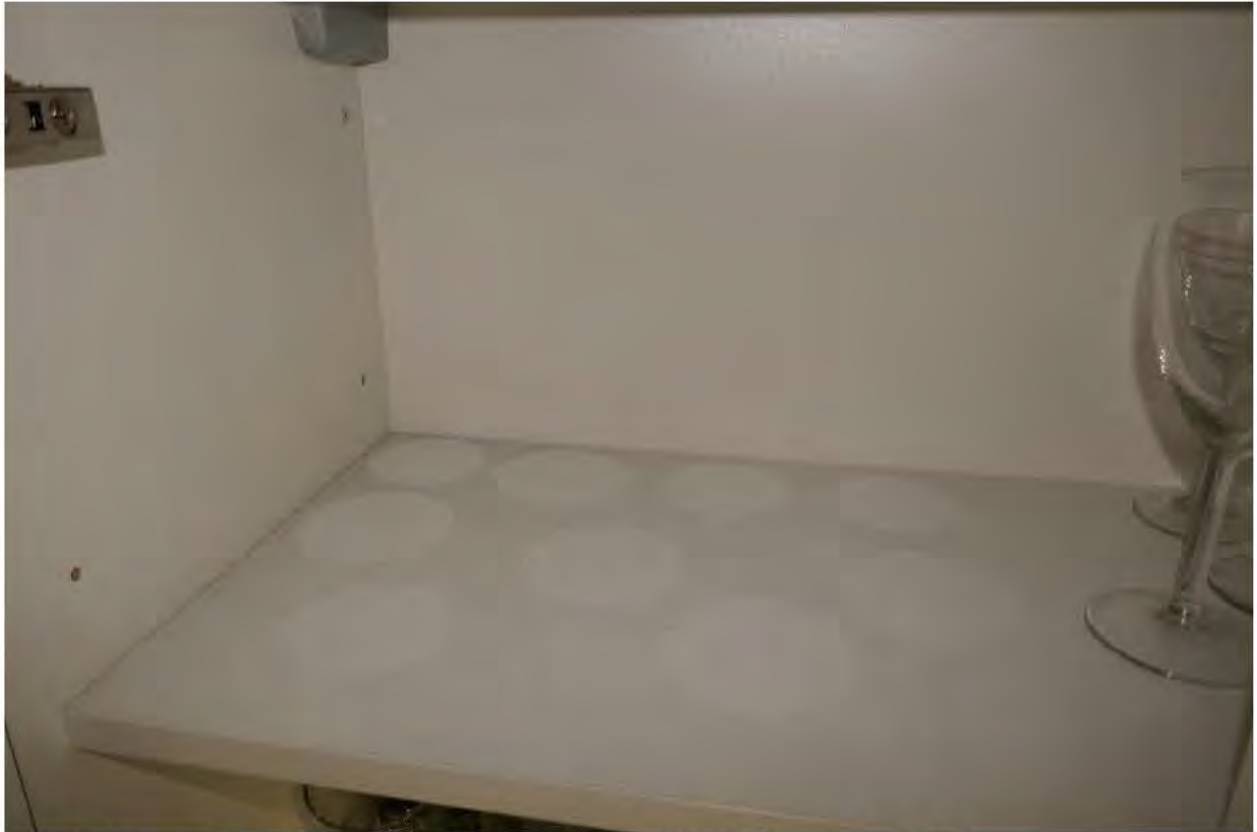
Foto 5. I samma köksskåp som bilden ovan fanns det sotbeläggning i skåpet.
