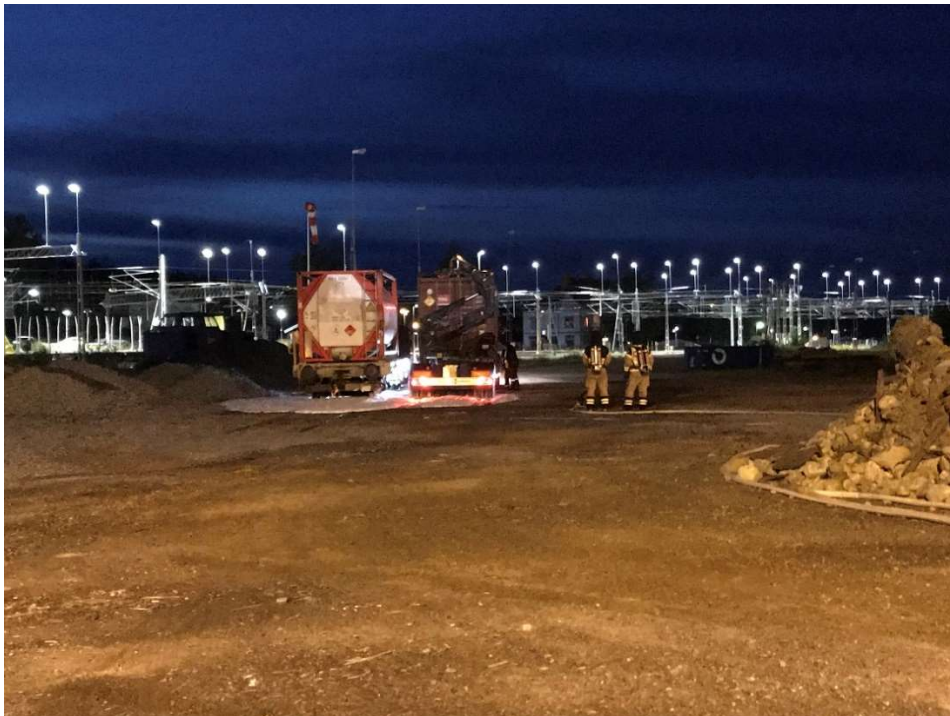
Bild 7: Järnvägsvagnen har flyttats och står enskilt. Den nya platsen har säkrats med skum och en kranbil är på plats för att lyfta bort containern med klorat från järnvägsvagnen. Under tiden arbetet pågår finns brandmän som håller beredskap ifall något oönskat inträffar.
