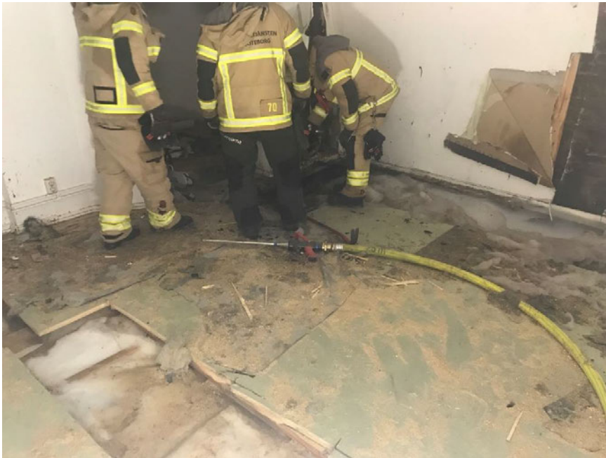
Bild 4 visar golvbjälklaget efter fyllning och friläggning. I bilden syns även CAFS-spettet. Källa RSG
