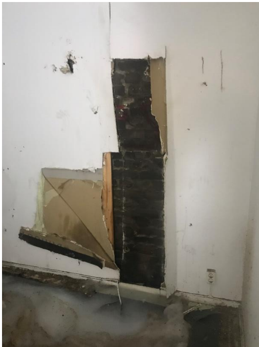
Bild 2 visar den varma väggen efter friläggning av ytskikt. Det var en brandmur mot intilliggande fastighet. Källa RSG
