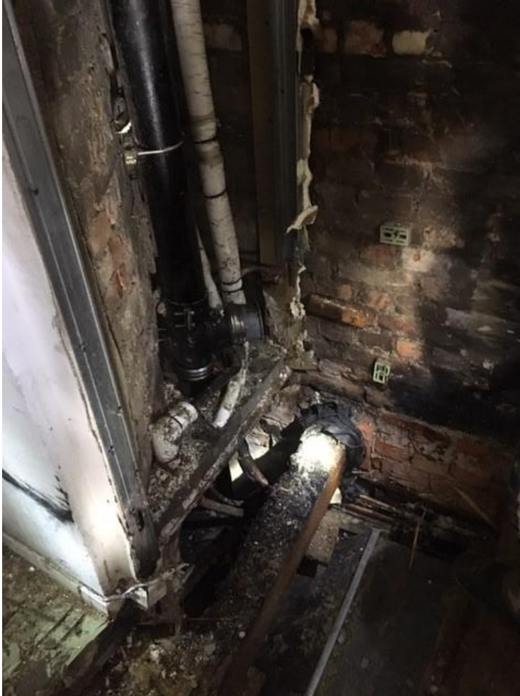
Bild 3 visar nischen med avlopps- och vattenrör efter friläggning. Nertill kan även ventilationen från köket under skymtas. Källa RSG
