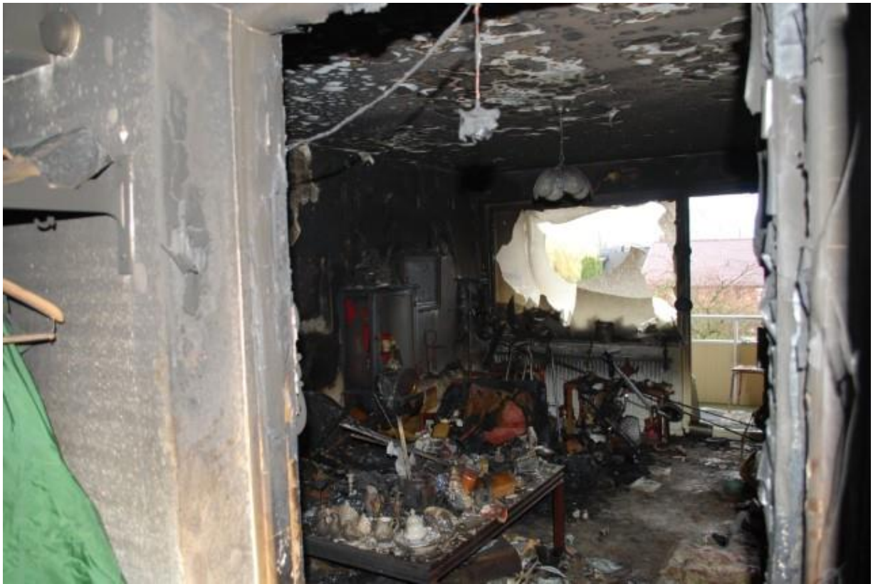
Bild 1. Brandskador i vardagsrummet.
