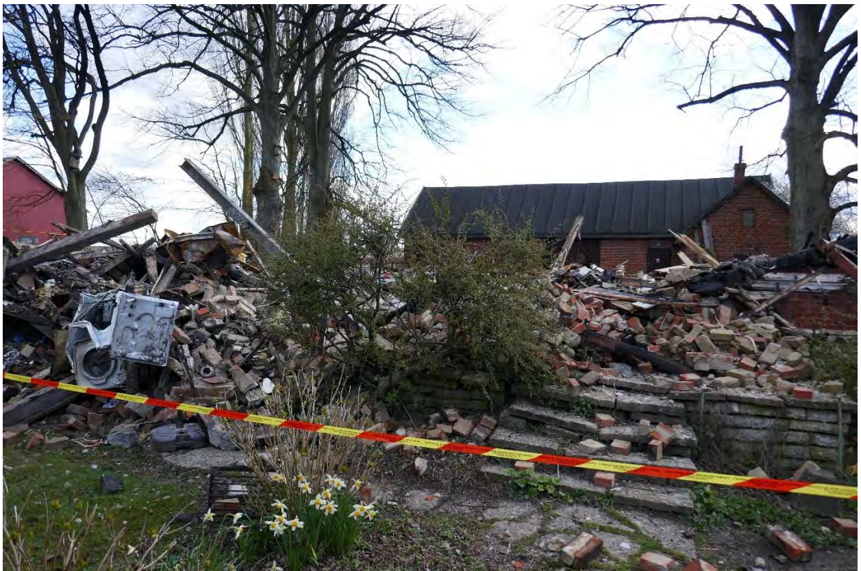
Foto 2 visar resterna av byggnaden
