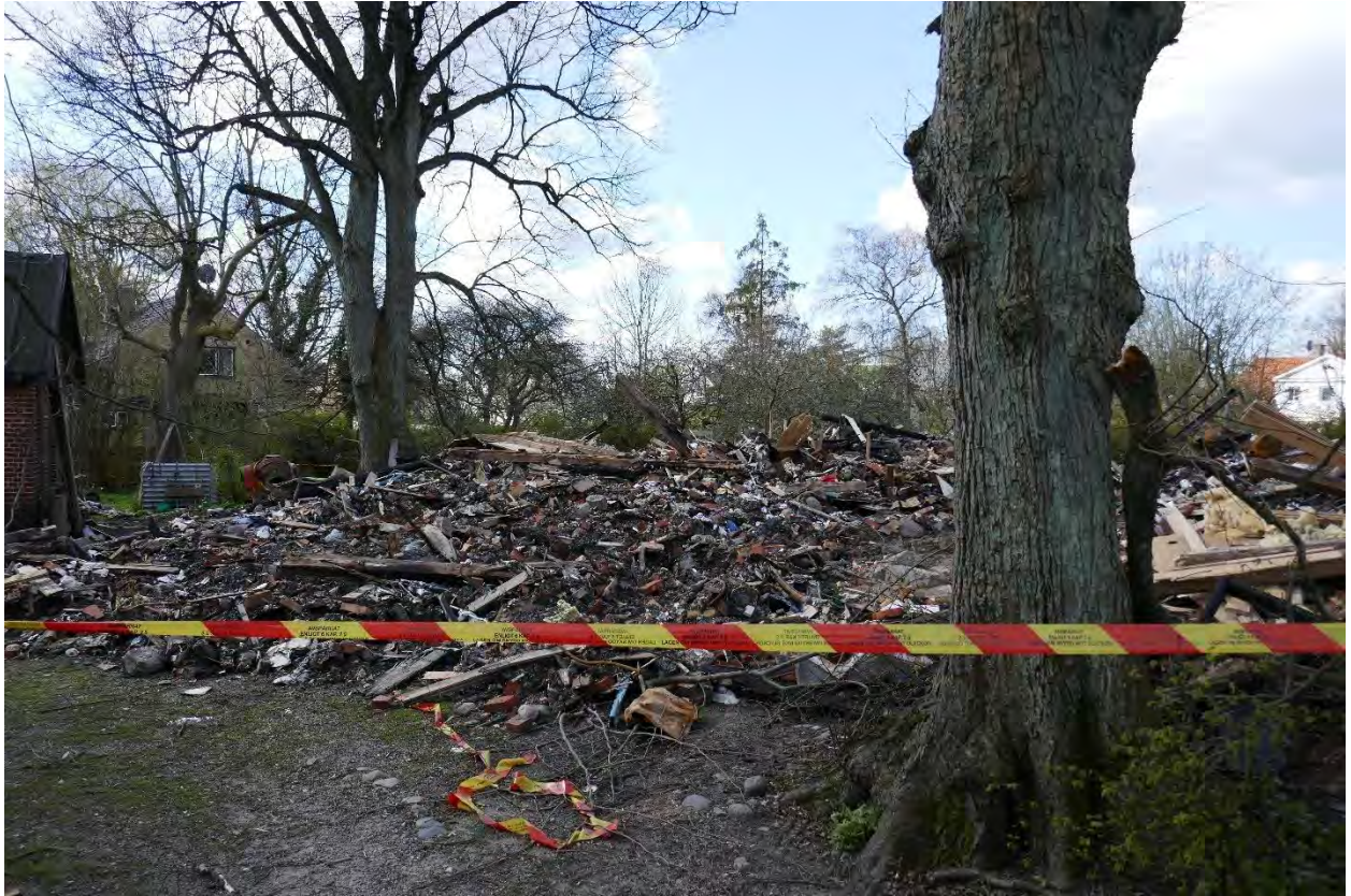
Foto 1 visar resterna av byggnaden
