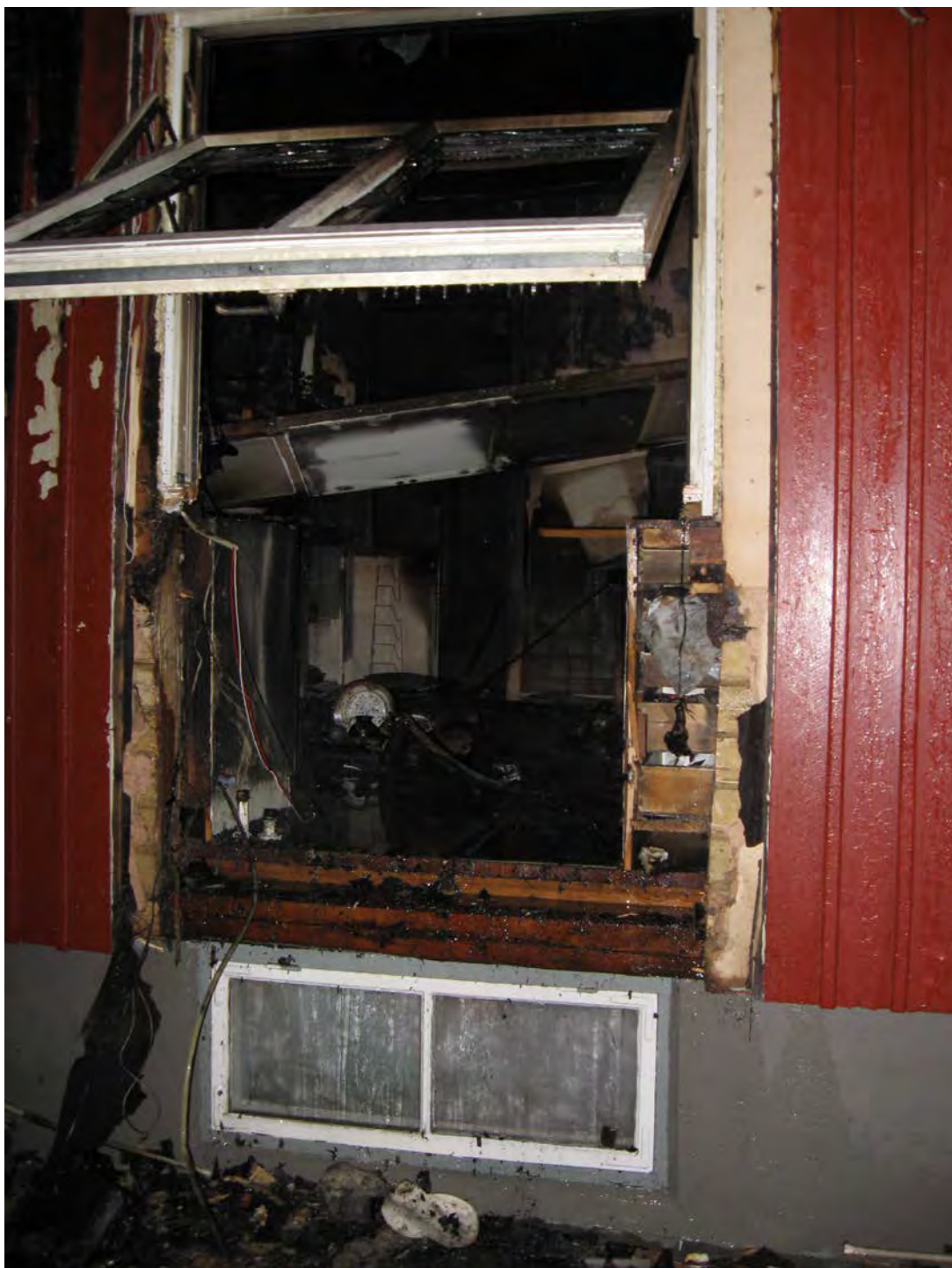
Bild 6 Håltagning i syfte att få ut personen ur köket.
