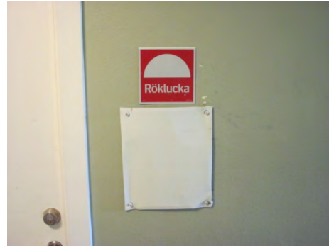
( Bild på luckan i trapphuset där man öppnar rökluckan )
