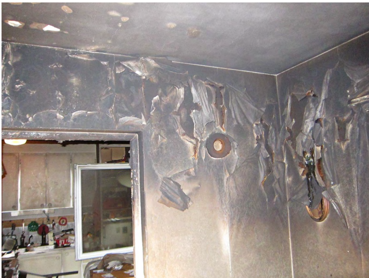
Bild 3: Sekundär skador i startutrymmet orsakat av varma brandgaser.
