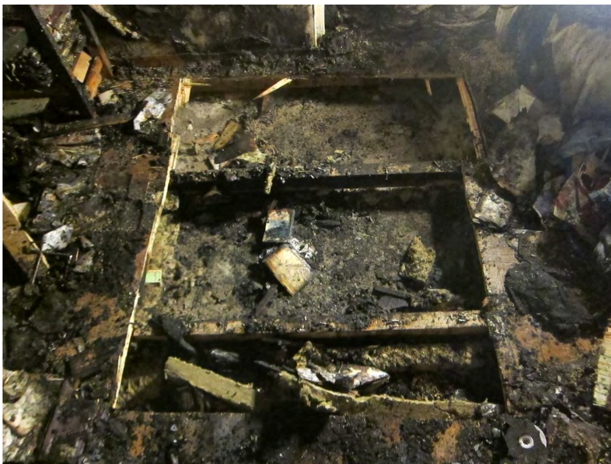
Bild 1: Hålet i golvet visar platsen där primärbranden startat.
