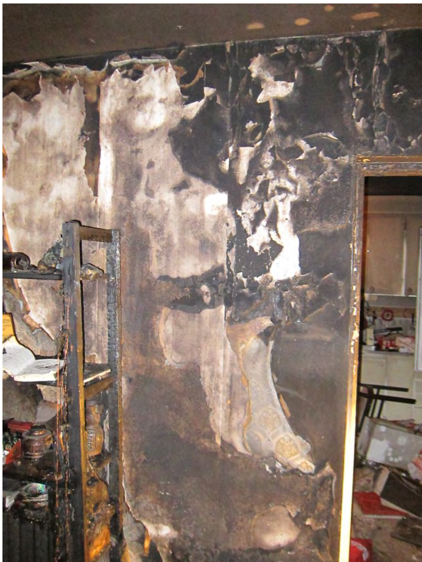
Bild 2. Sekundär skador i starturtrymmet orsakat av varma brandgaser.
