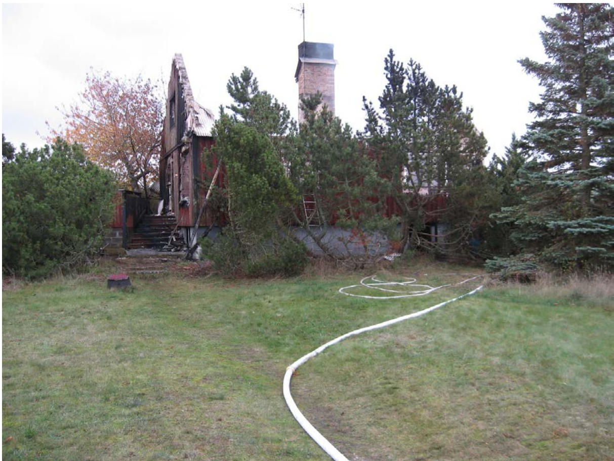
Bild 1. Återstoden av huset dagen efter branden.
