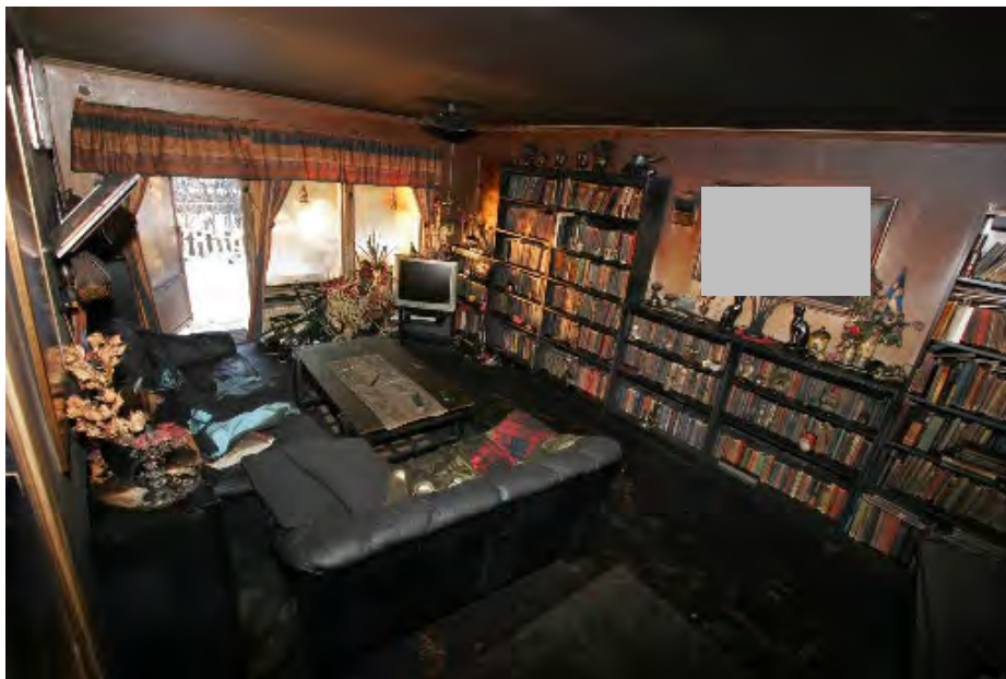
Bild 6. Visar vardagsrummet, tjärbildningen är omfattande i hela våningsplanet.
