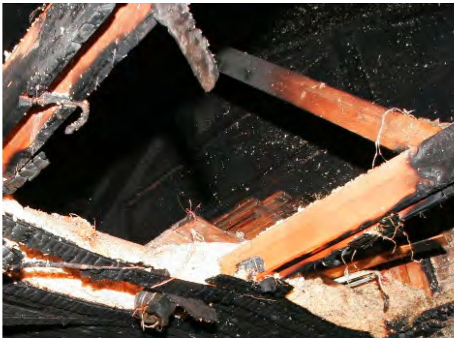
Bild 2. Visar detalj av bjälklaget mot vinden. Råspont, kutterspån och takpanel
