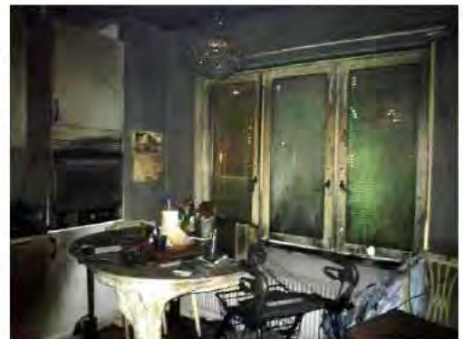
Fig 4: Rök och värmeskador i köket
