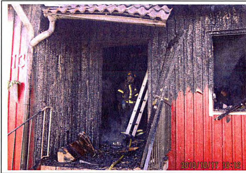
Bild 1. Visar entren till villan. Här fick rökdykarna jobba hårt för att släcka ner och komma in i bostaden för genomsökning och hitta kvinnan.
