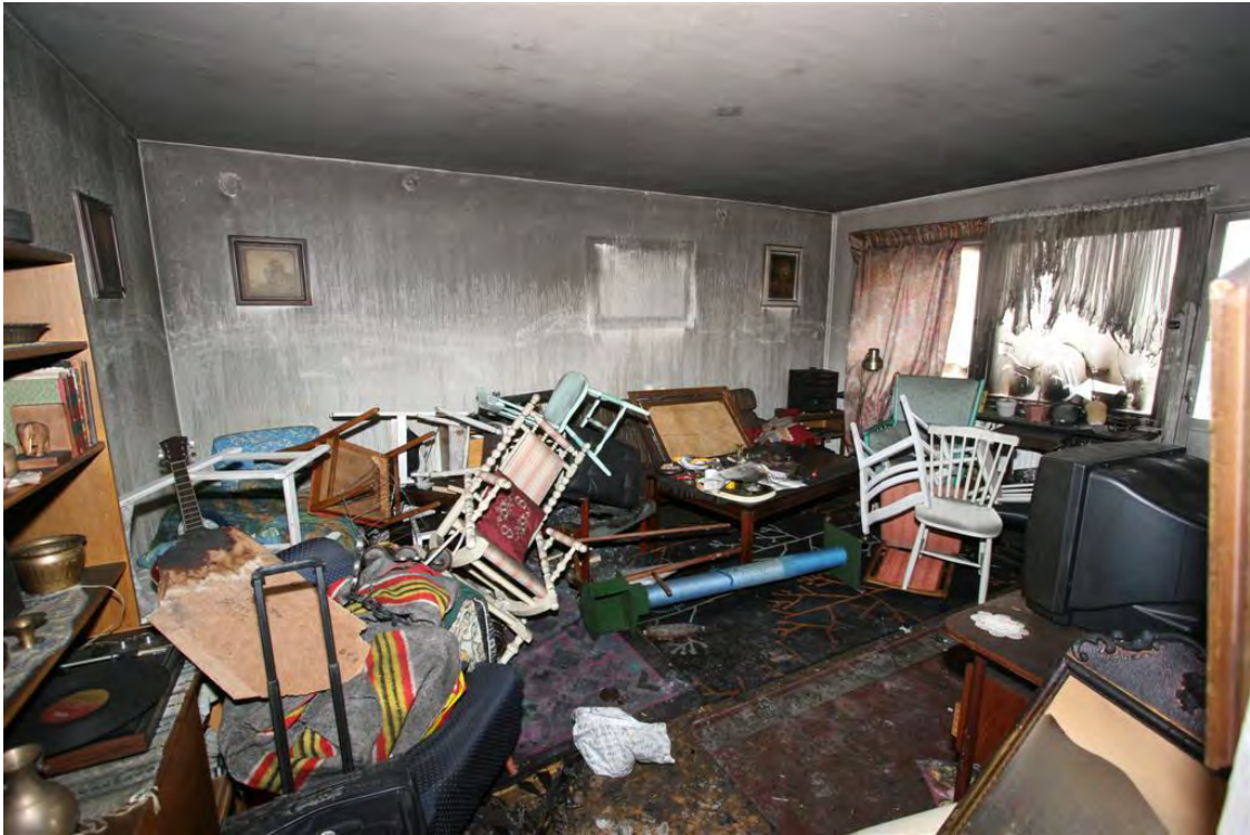
Bild 3. Vardagsrummet med stora rök och värmeskador.
