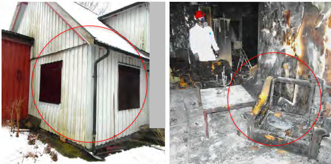
Figur 1 och 2, Översiktsbild på den del av villan som innehöll det av brand drabbade vardagsrummet samt en trolig plats för initialbranden(rekonstruerad bild).
