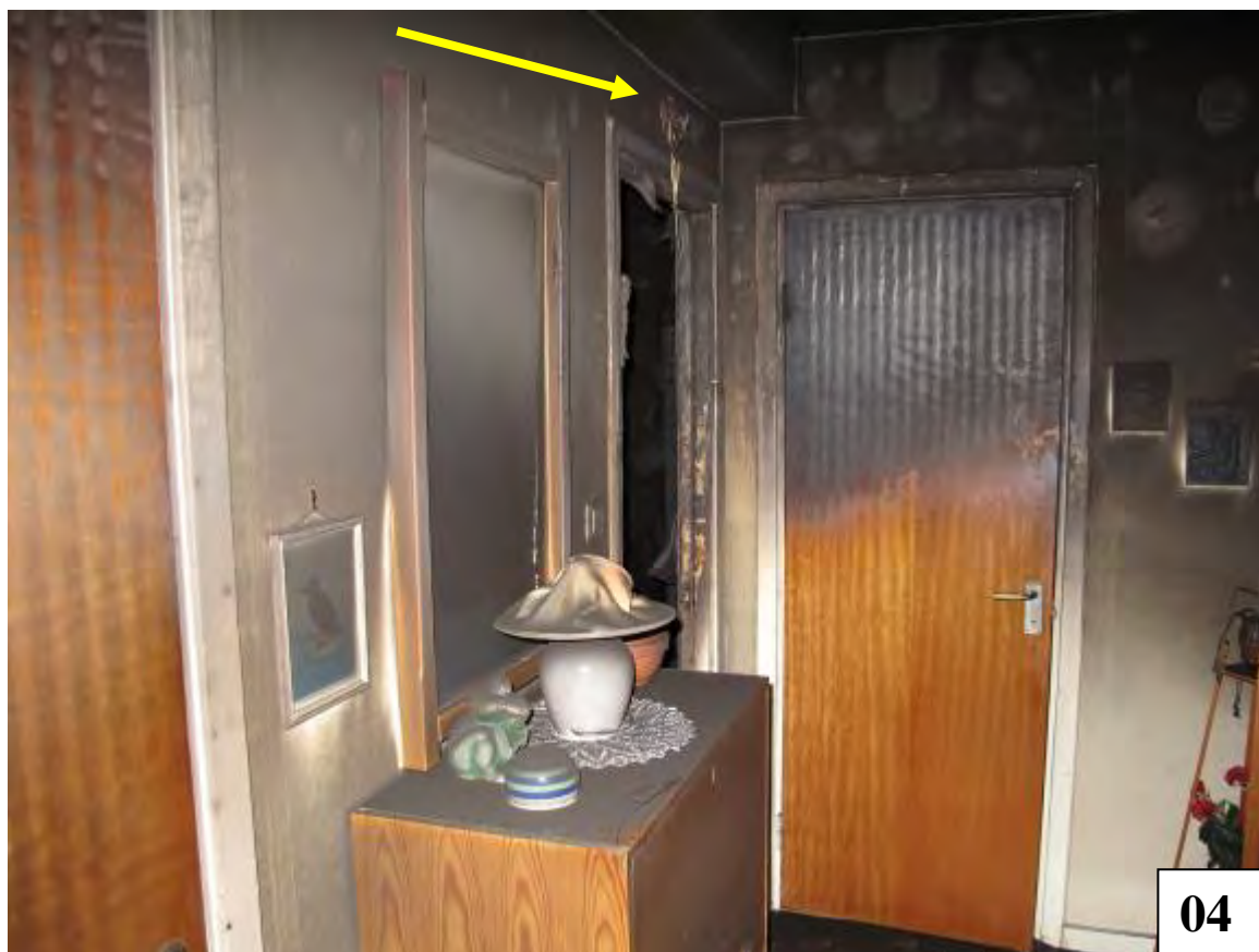
Pilen visar på brandvarnaren som saknade batteri enligt rökdykarna. Ingången under brandvarnaren leder till brandstarttrummet, som är sängkammaren.
