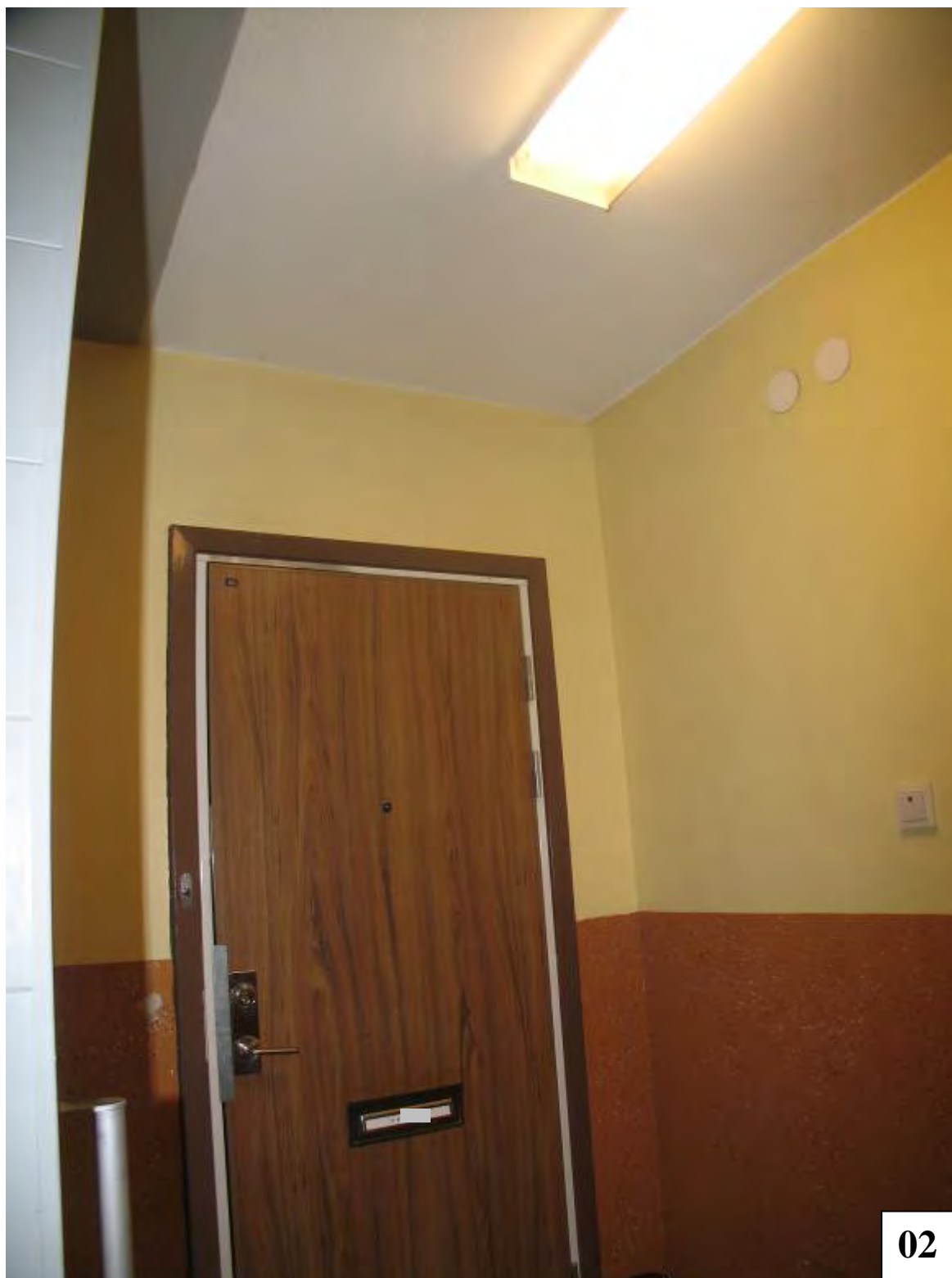
Bilden tagen på lägenhetsdörren i trapphallen, inga synliga röskador.
