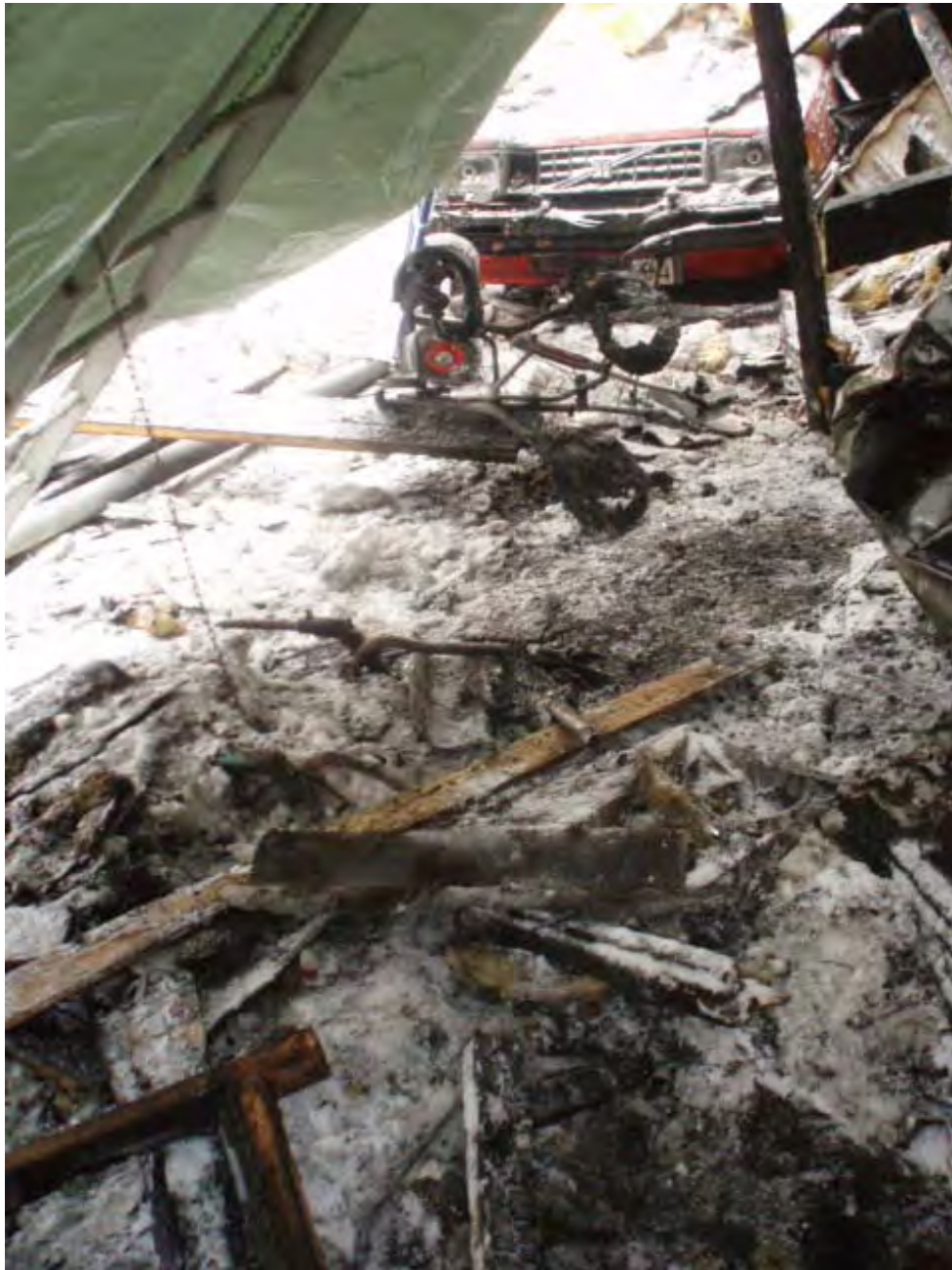
Bild 7: Rester av de båda rullatorer som påträffades utanför entrédörren under det nedrasade carportstaket.
