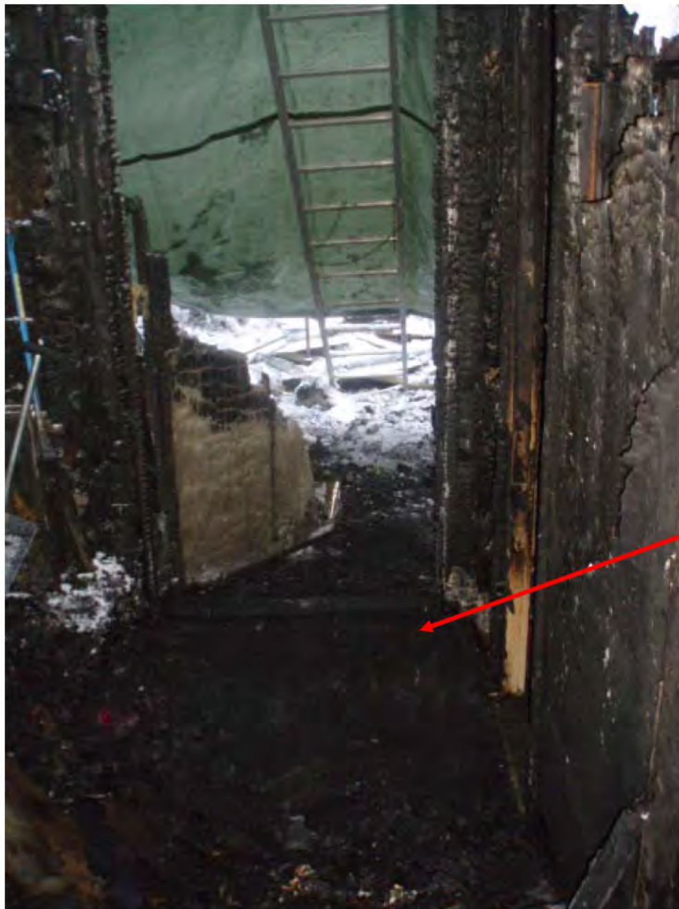
Bild 8: Vy från hallen mot entrédörren. Genombränning vid röda pilen.
