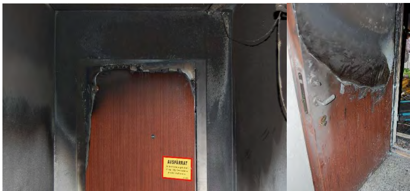
Bild 6 visar brandbilden på lägenhetsdörren till brandlägenheten. Källa RSG
