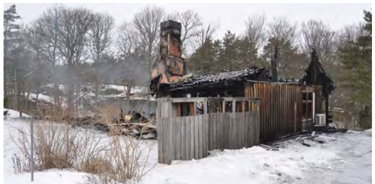
Bild 2. Visar vad som fanns kvar av huset efter branden. Foto Polisen.
