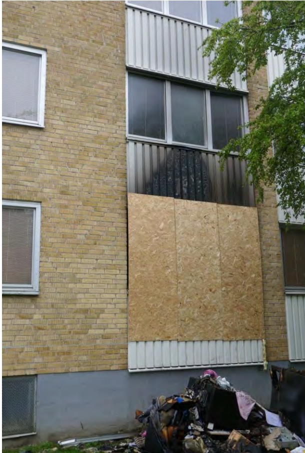
Foto 4. Förspikat fönster till vardagsrummet ut mot innergården.
