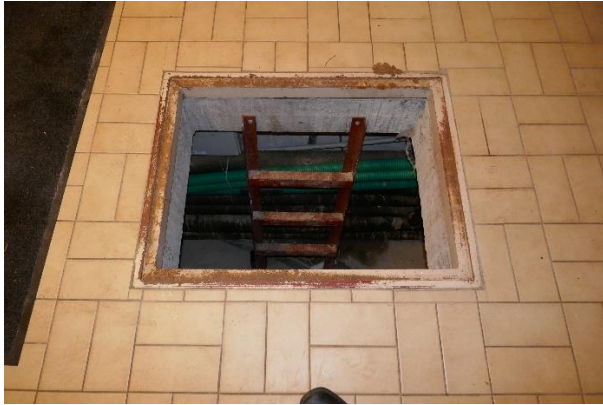
Bild 2 lucka till kulvert
