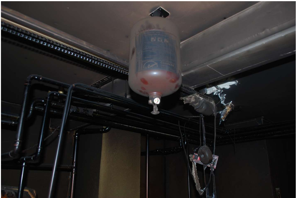
Foto 4. Utlöst pulversprinkler.
