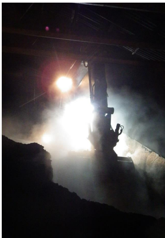
Bild 4 visar lämpningsarbete med grävmaskin
