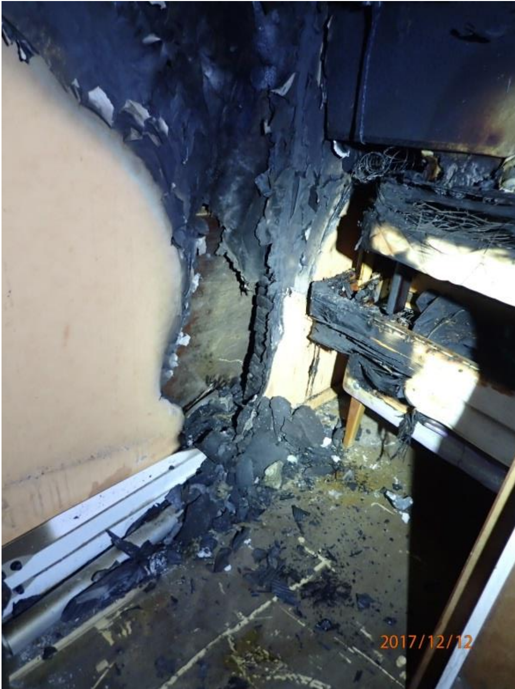
Bild 2 Visar andra sidan väggen till primärbrandrummet.
