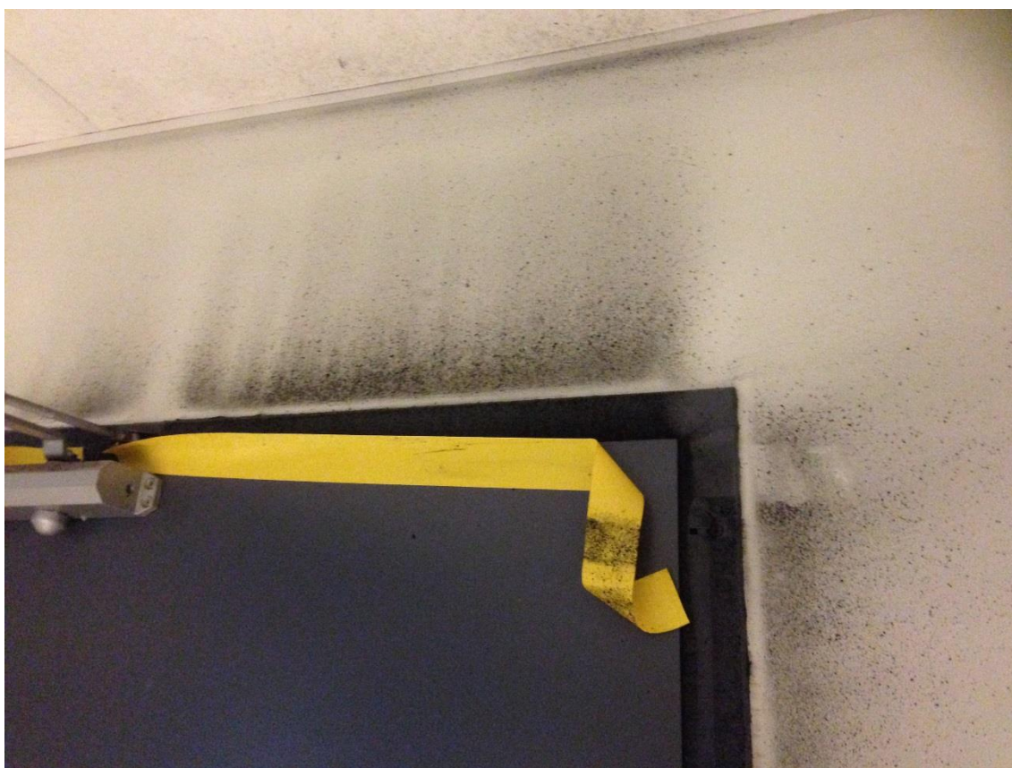
Otätheter i brandcellsgräns (dörr)
