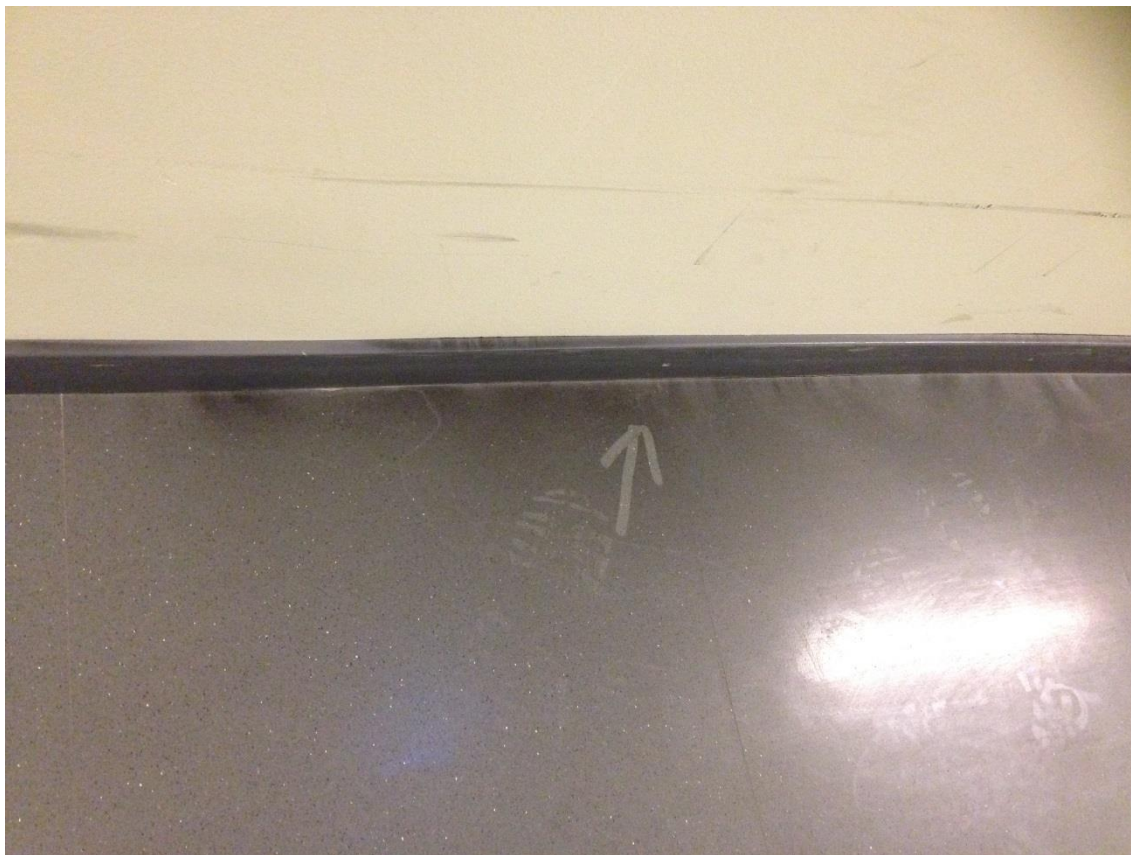
Rökspridning från mellanvägg (sockel)
