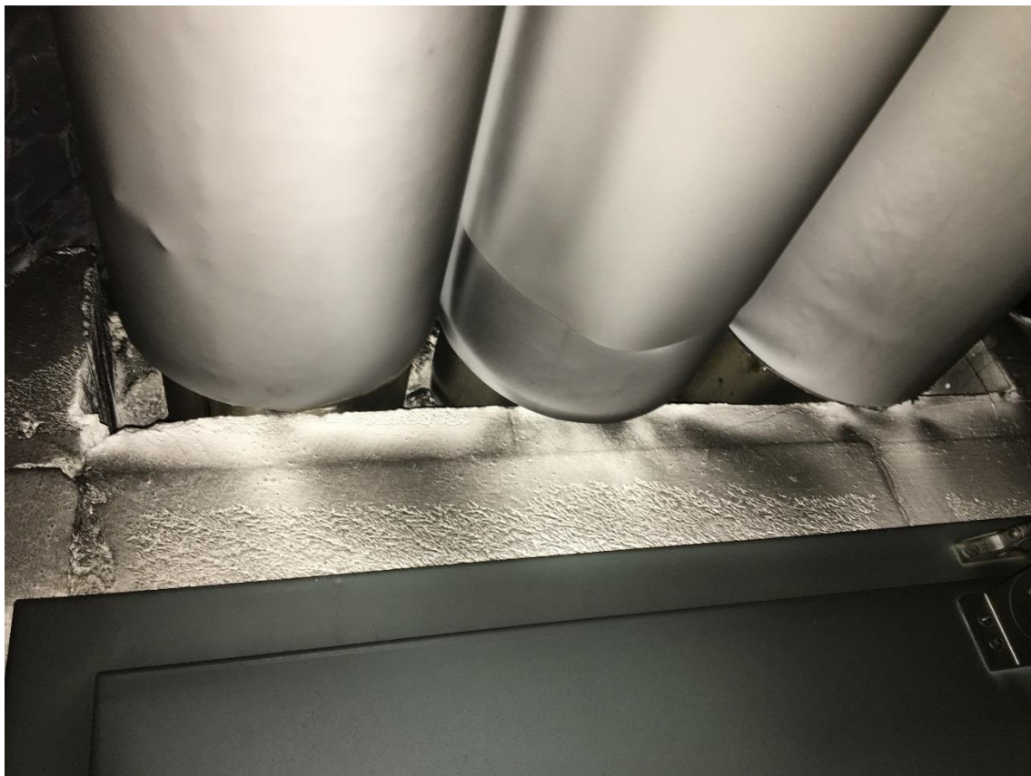
Otätheter i brandcellsgräns (rör genomföring)
