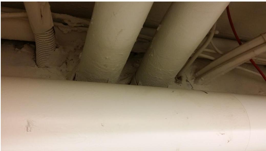
Genomföringar som normalt är dolda av ett undertak
