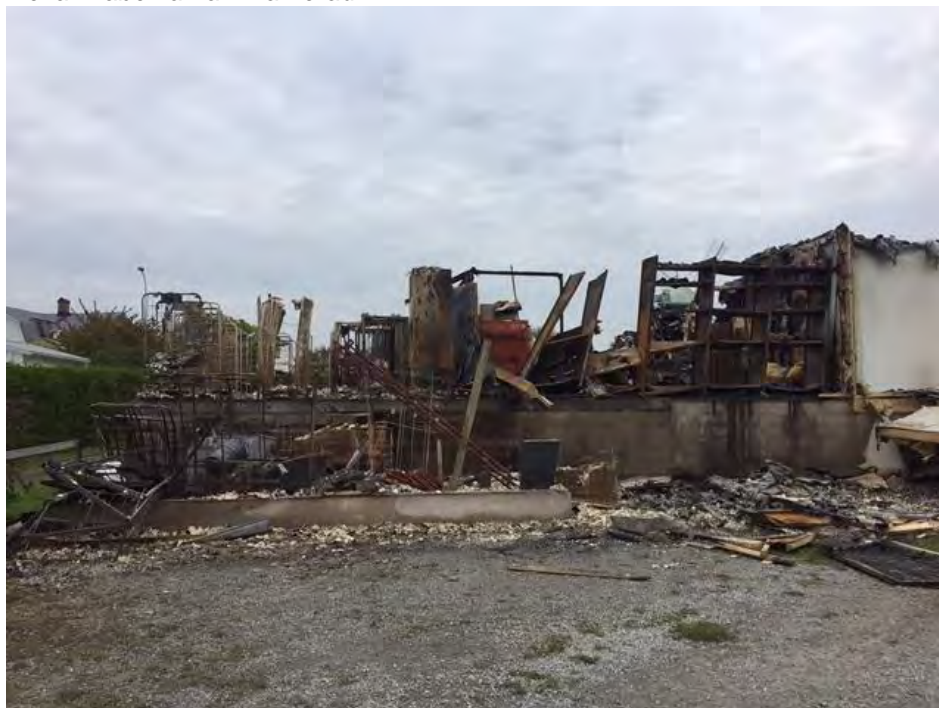
Del av byggnaden västra sida.
