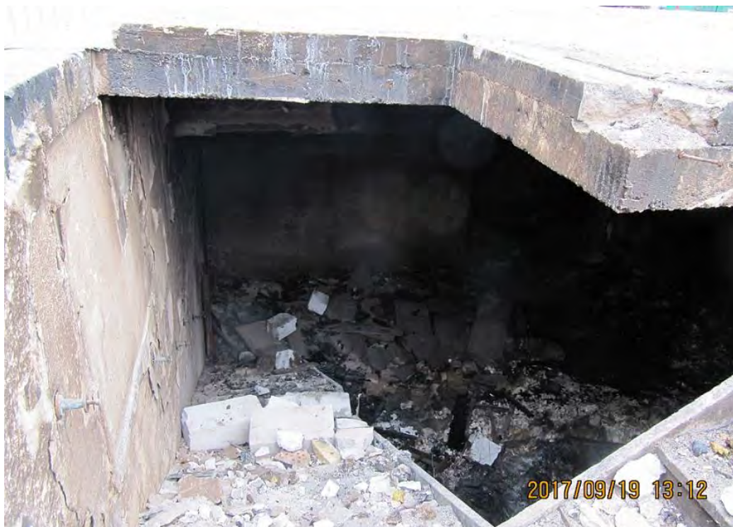
Bild 13: Trappen ner i källaren.
