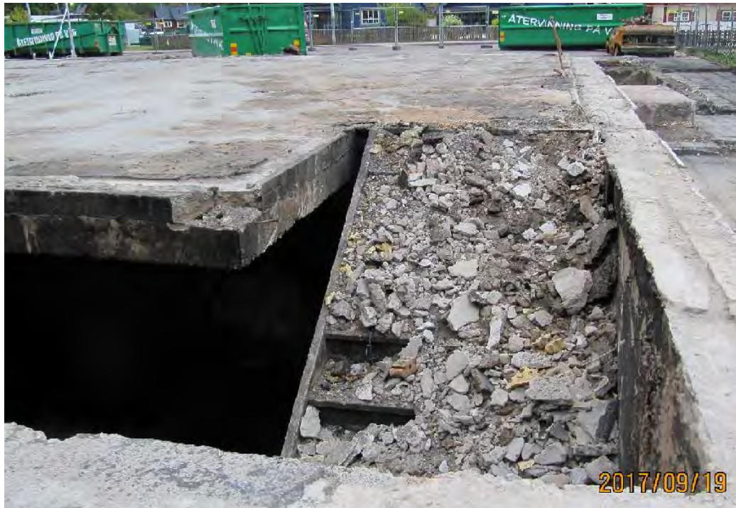
Bild 12: Trappen ner i källaren.
