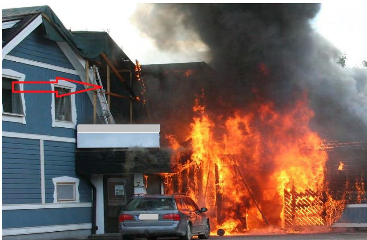
Bild 7: Pilen visar på var det saknades takplåt p g a renovering.
