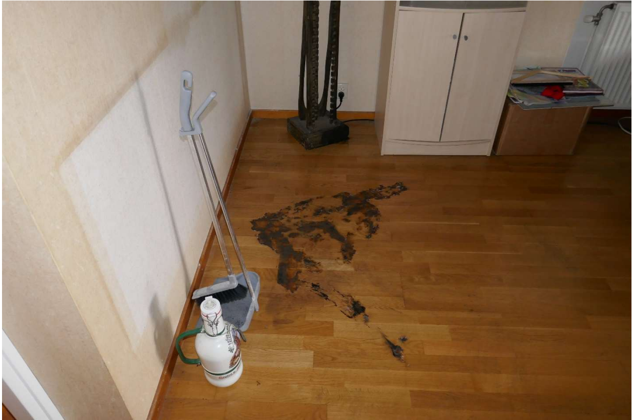
Foto 2. Brandskador i vardagsrummet.
