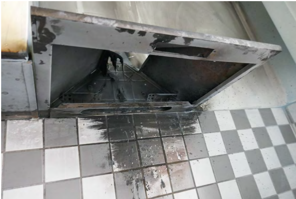
Foto 2. Brandskador på spisfläkt.
