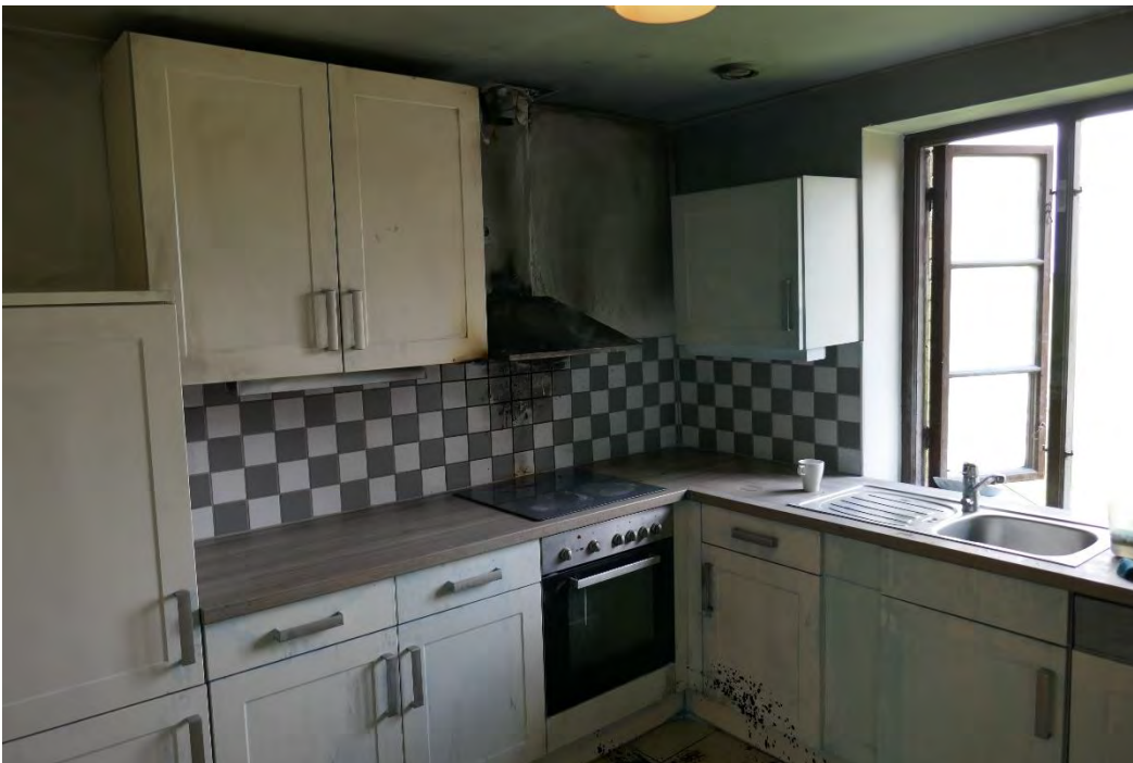
Foto 4. Sotskador på väggarna i köket.
