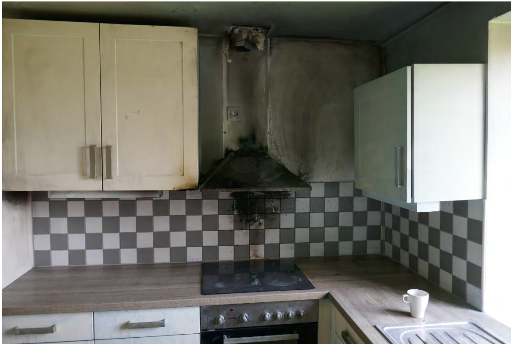
Foto 1. Brandskador på spis.
