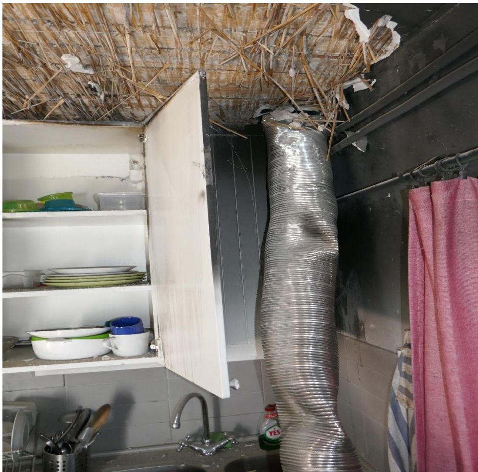
Foto 1. Brand- och sotskador i köket.
