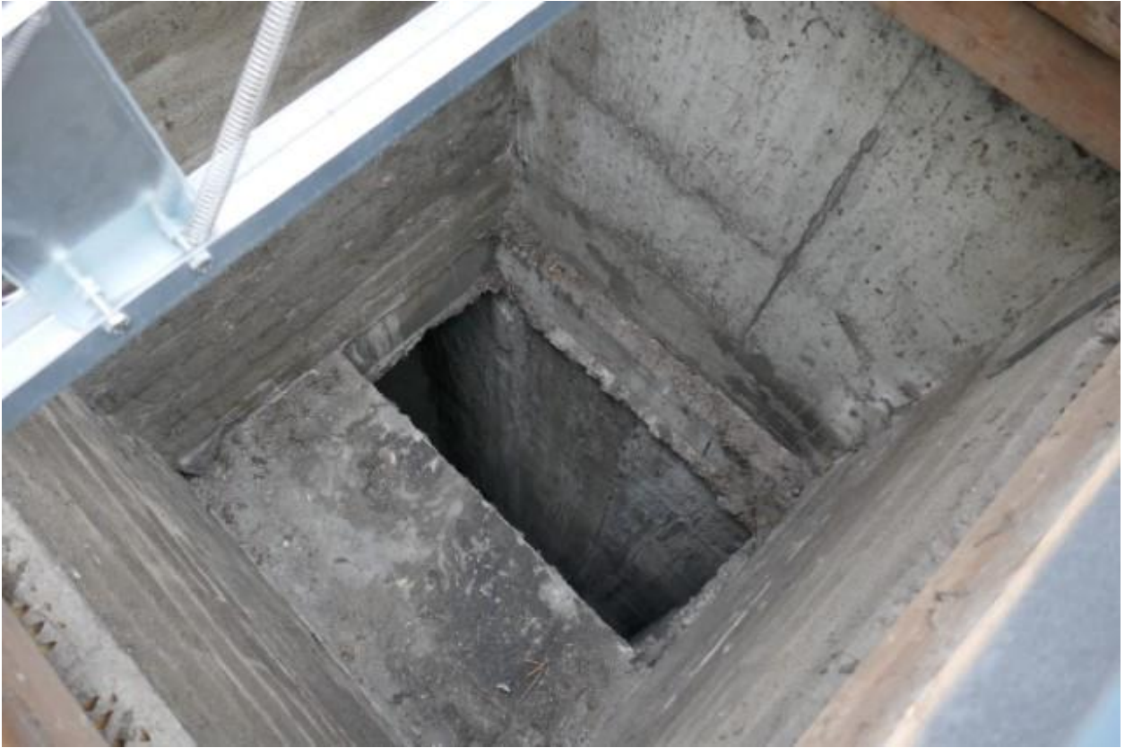
Bild 3. Schaktet ner till parkeringsgaraget uppifrån luckan
