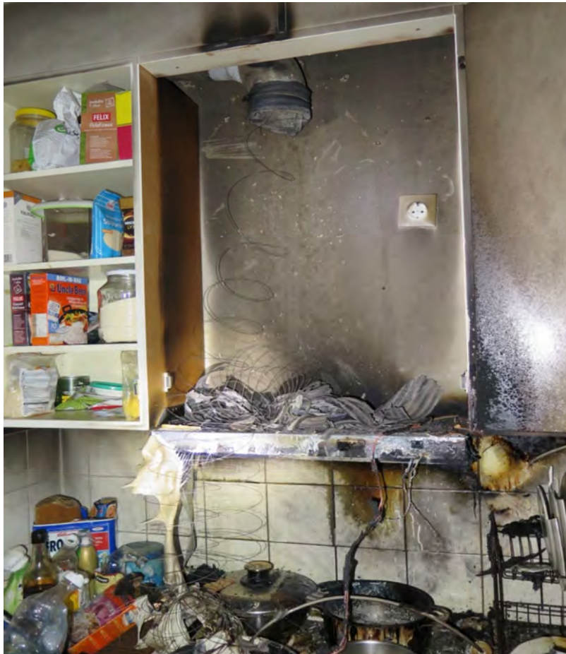
Bild 4. Räddningstjänsten demonterade flätskåpet.
