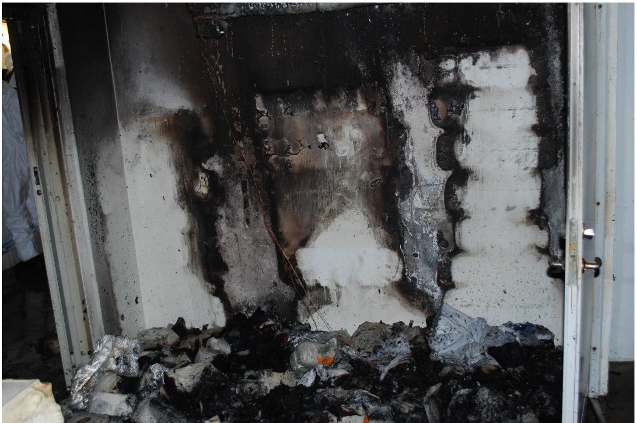
Foto 2, förrådet där det brann fanns det torkpapper staplat mot ena väggen, där branden tros startat.
