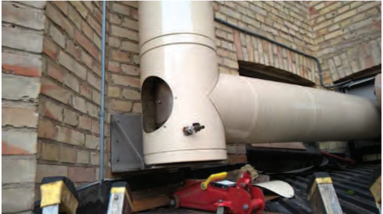
Foto 4. Inspektionsluckan i den nedre delen av röckkanalen.
