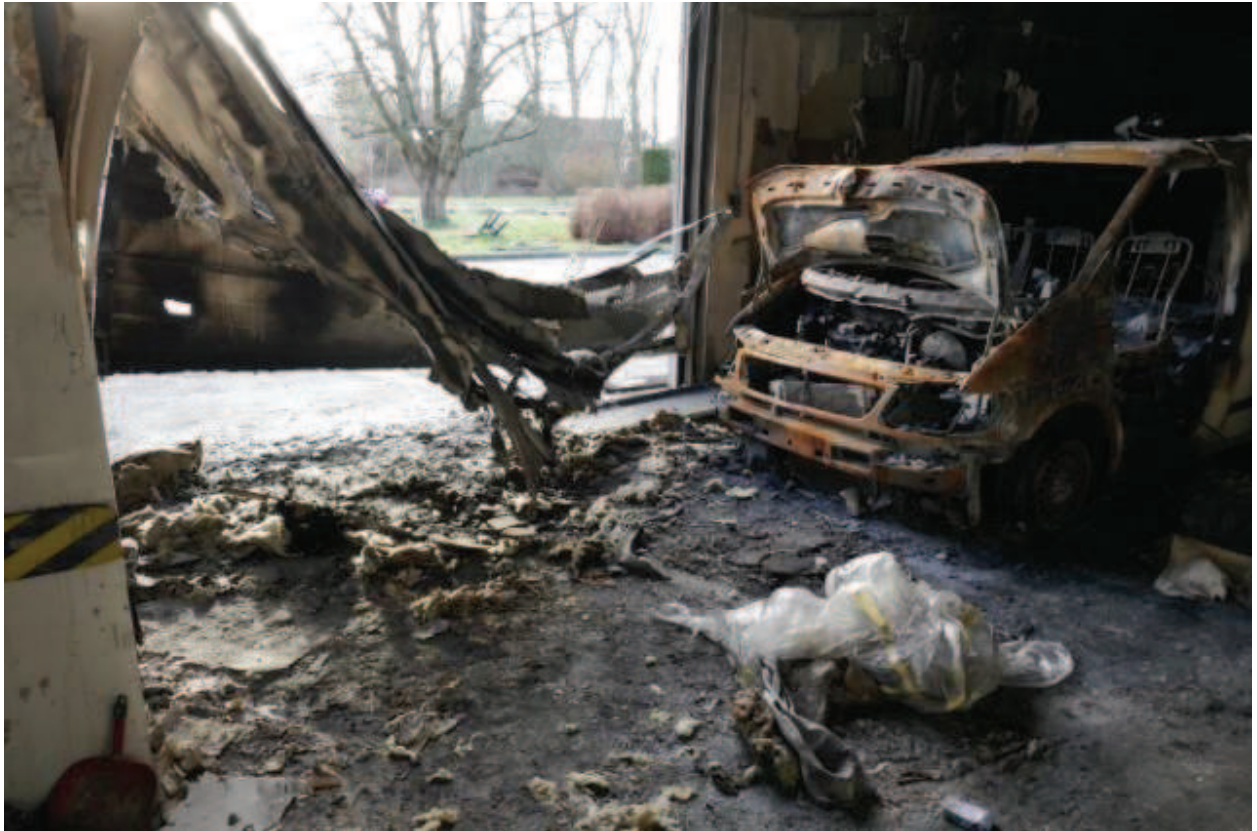
Bild 5. Brandskador på port och skåpbil.
