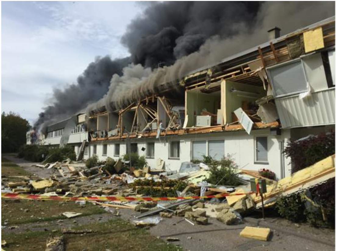
Figur 6: Byggnadens södra fasad efter inträffad explosion.
