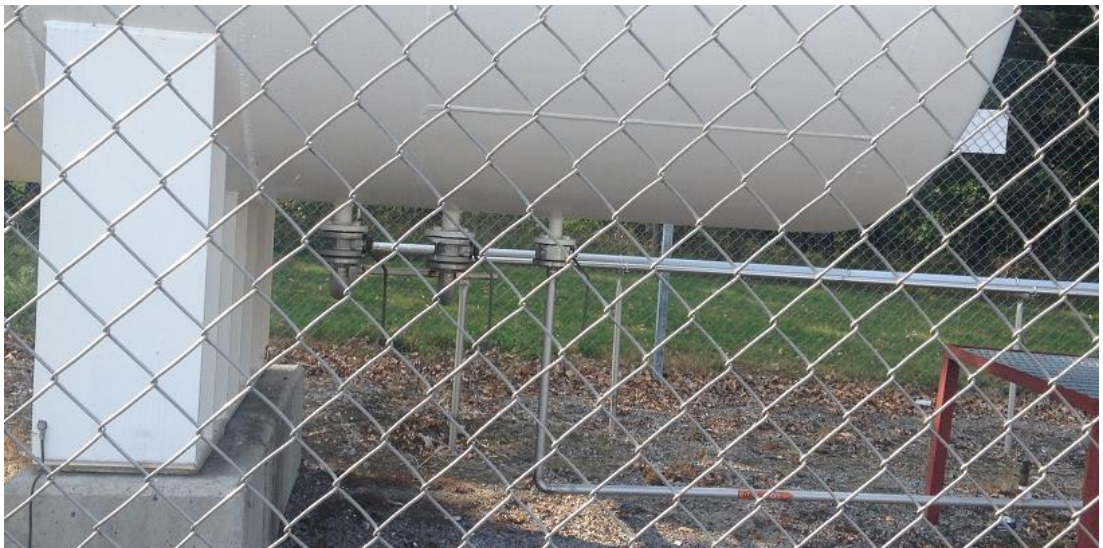
Figur 4: Gasolcisternens bottenventiler.
