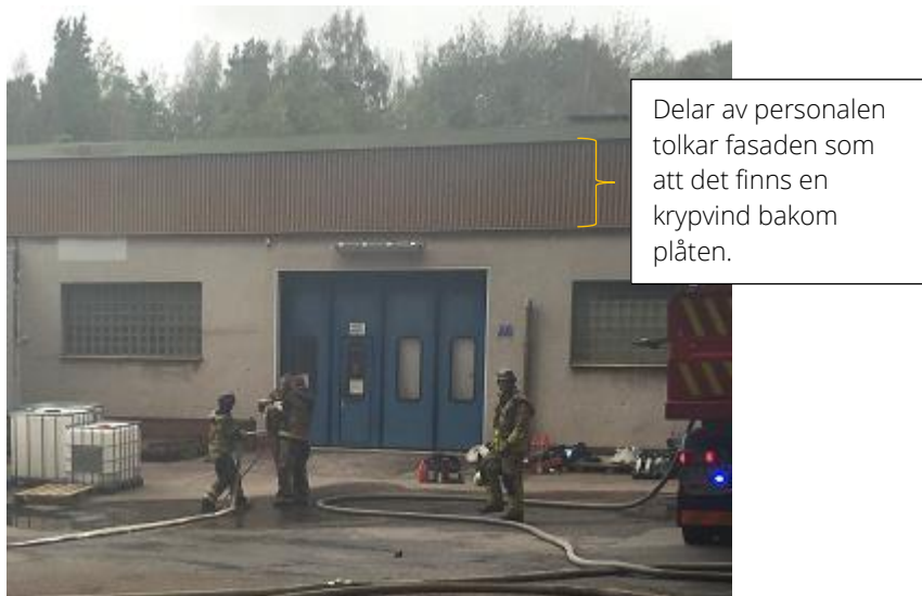
Figur 5: Byggnadens fasad med ingången till verkstadshall C.
