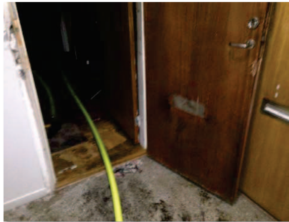
Bild 4. Brandlägenheten från trapphus
