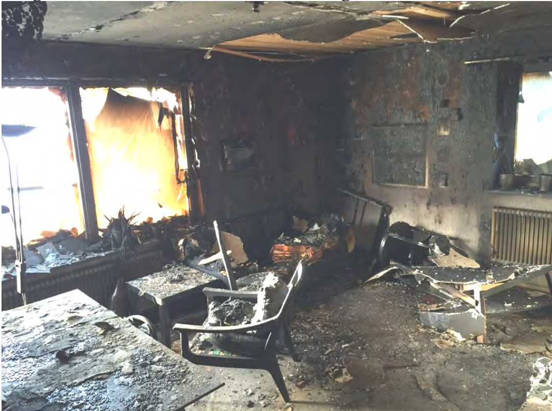
Bild 1: Översiktbild över vardagsrummet med soffan placerad i det borte hörnet.
